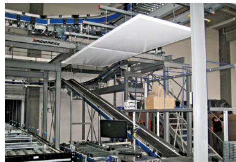
Eine Infrartheizung kann je nach Raumumgebung an der Wand oder wie an diesem Arbeitsplatz an der Decke installiert werden
